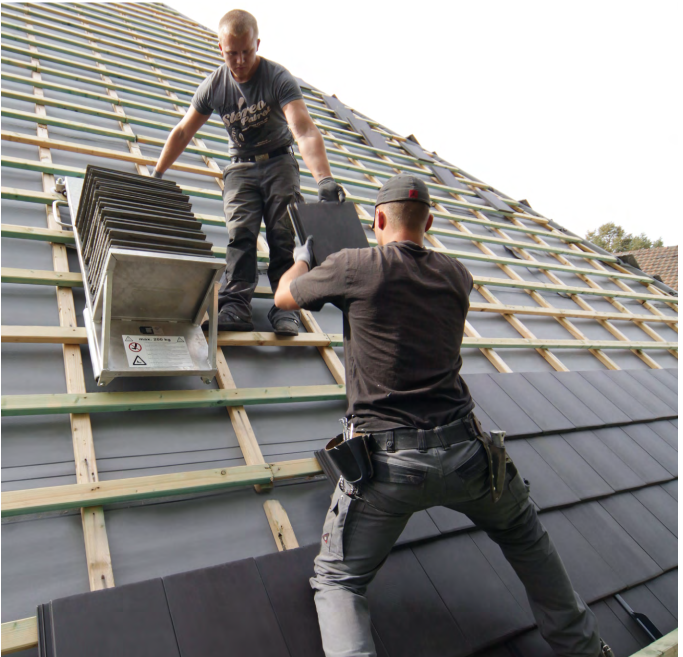
Abbildung 22: Verlegung am Dach; Quelle: BMI Steildach GmbH
